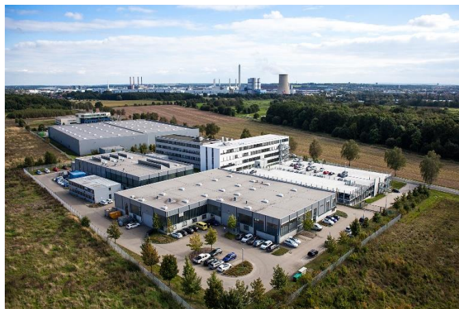
Quelle: Harpen Immobilien GmbH, Urheber: COPTOGRAPH
